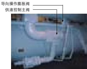
制冷剂流量调节装置
